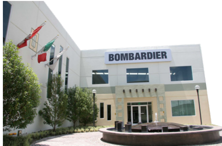
El Marques Industrial Park
